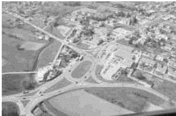
La viabilità ad Antraccoli, uno dei nodi del progetto
