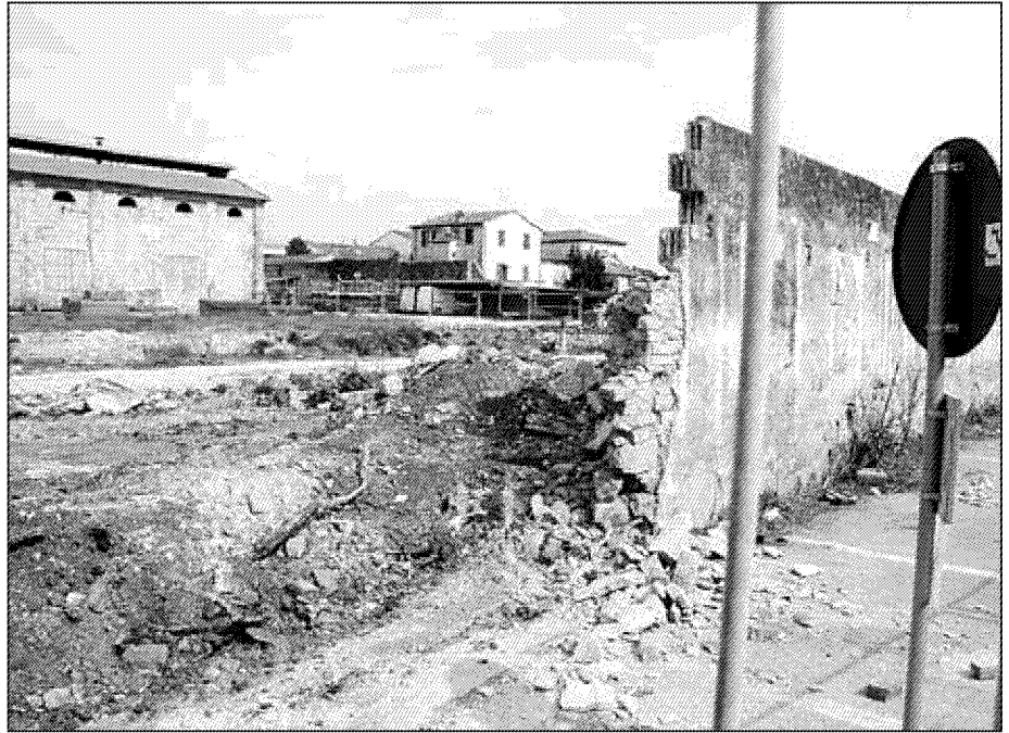
L'area dello Steccone nella fase iniziale dei lavori
