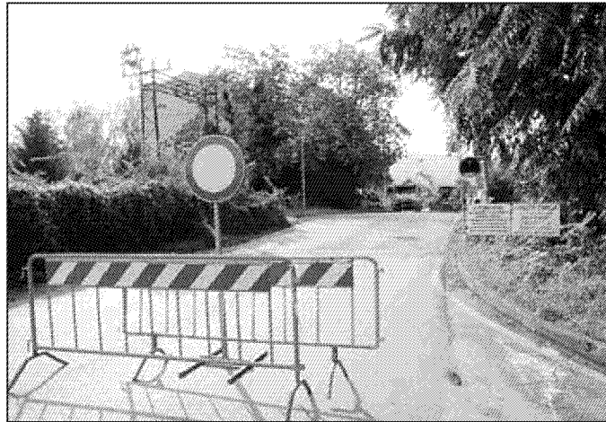
La zona dei lavori al sottopasso
