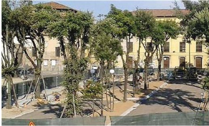
I lavori in piazzale Verdi (Vip)
