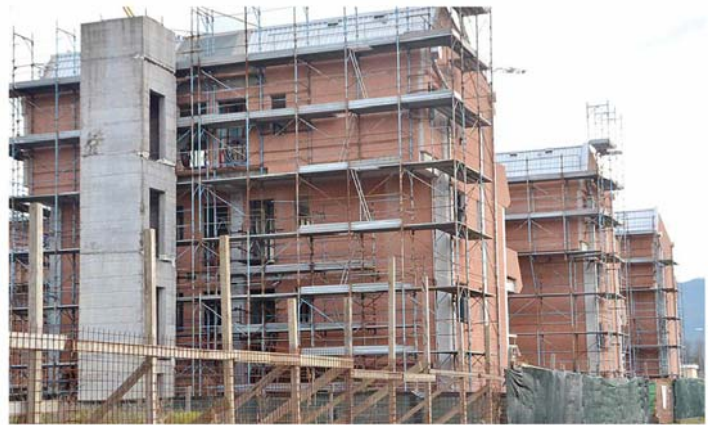
Un cantiere per l'edilizia popolare a Pontetetto (Foto d'archivio)
