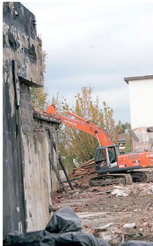
ALL'OPERA Una delle ruspe che da mercoledì sta lavorando nell'area dell'ex Uba-Uba per abbattere quello che resta del fabbricato (Alcide)
