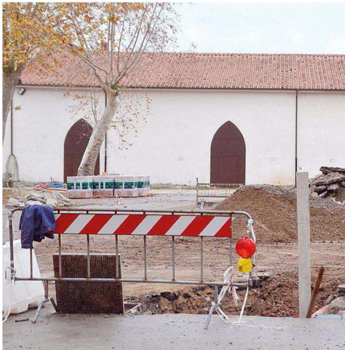
Il cantiere aperto all'ex caserma Lorenzini (foto di archivio)
