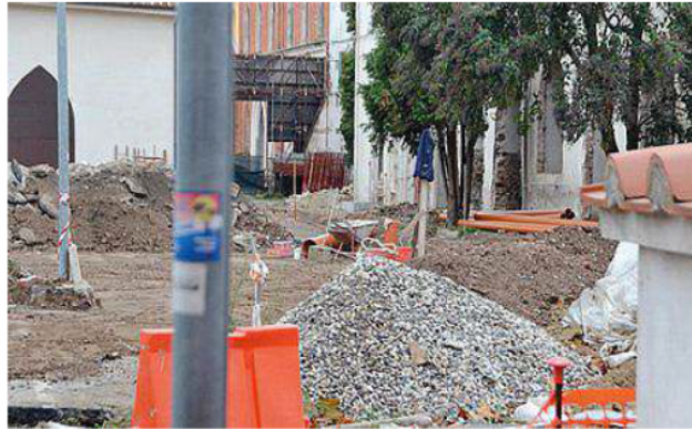
Il cantiere infinito all'ex caserma Lorenzini (foto di archivio)
