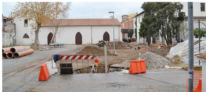
L'ex caserma Lorenzini durante i lavori (foto d'archivio)
