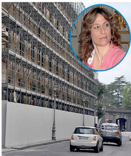
STRATEGIE La facciata dell'ex Manifattura coperta dalle impalcature e, nella foto tonda, l'assessore Mammini
